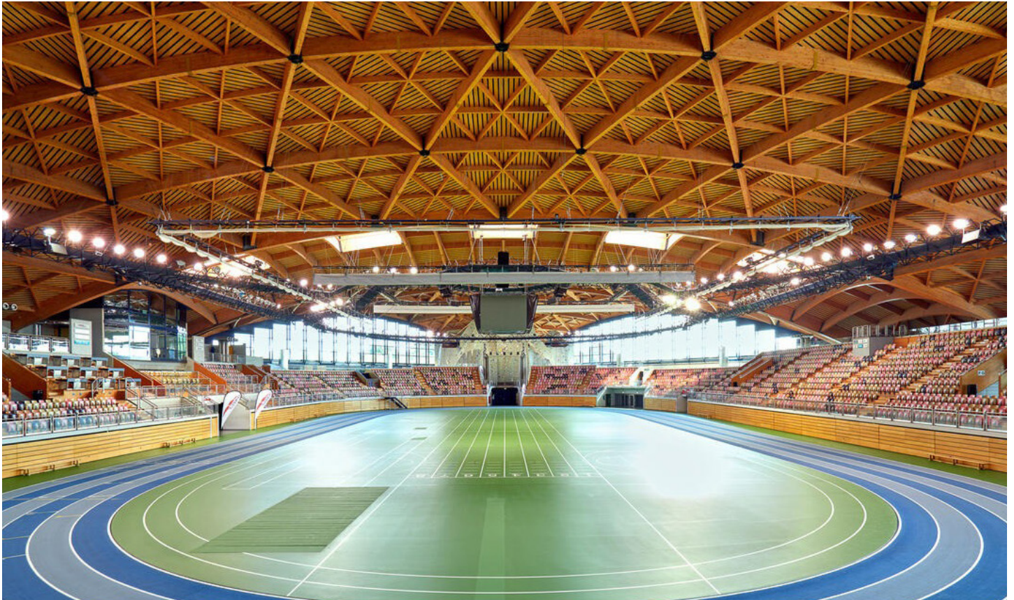
In Holzbauwerken (hier Nationales Sport- und Kulturzentrum in Luxemburg) wird Kohlendioxid über viele Jahre gespeichert.
