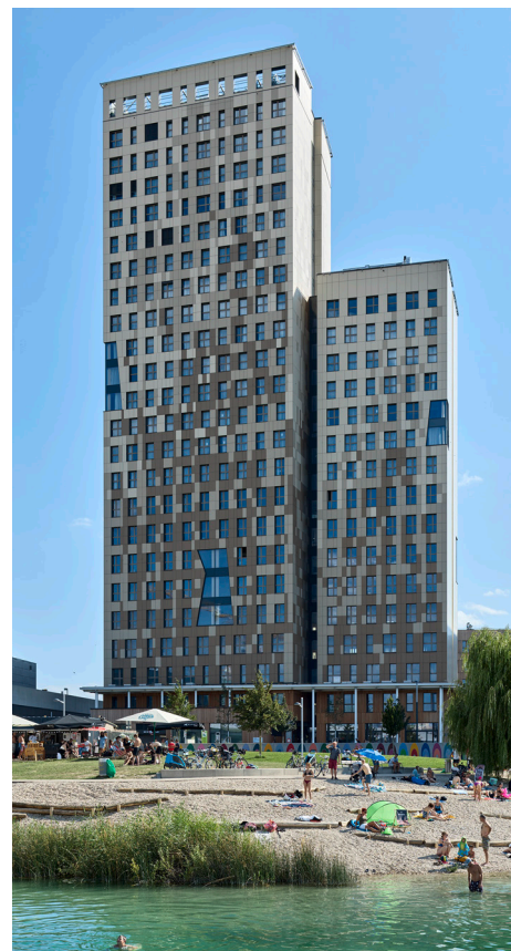
Der Einsatz von 800 Holzstützen aus Fichte anstelle von Stahlträgern im 84 Meter hohen Hoho Wien spart die CO 2 -Emissionen der energieintensiven Stahlproduktion ein.
