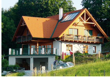
Abb. 3: Gebäudeklasse C, Altbau jünger als 30 Jahre Foto: Holzbau Weiz
