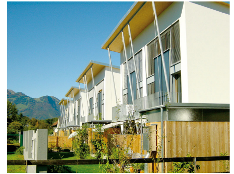
Abb. 5: Gebäudeklasse A, entspricht Niedrigstenergiehaus Foto: Konzett
